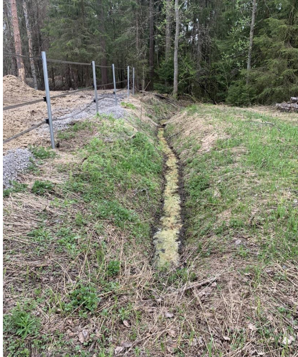
Figur 19. Dike som leder avrinnande vatten från privathästhagarna till Tvärån. (Tyréns Sverige AB, 2023)
